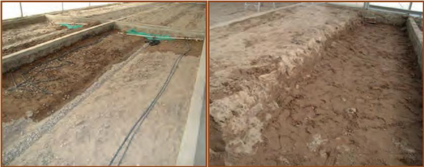
Figura 13. Canaletas llenas de arena de río, con sistema de drenaje
