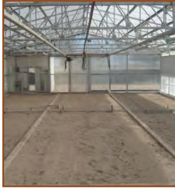
Figura 11. Canaletas de cemento
