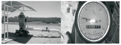
Figura 32. Medidor volumétrico instalado en el pozo.
