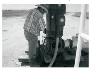
Figura 35. Determinación del nivel dinámico mediante la sonda neumática.
